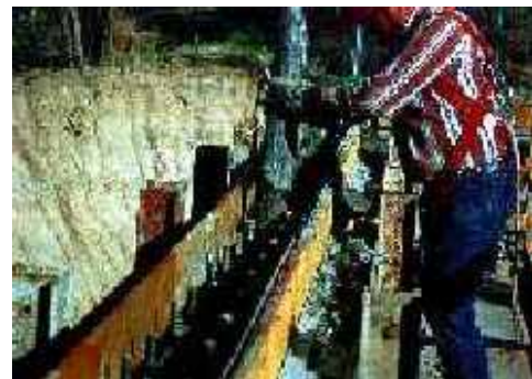
Pour concrete walls
